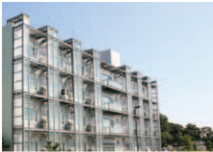
彩都バイオインキュベータ。彩都にある 3 棟のインキュベーション施設の 1 つで、公設民営形態で運営されている。
